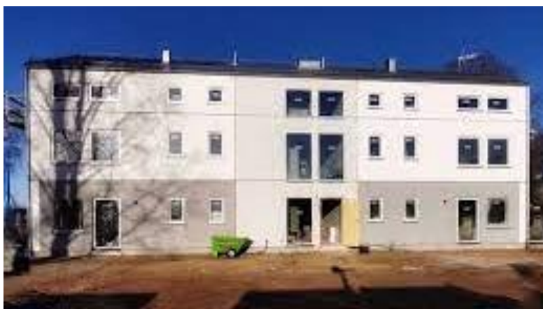
Figur 14, Flerbostadshus med energiprestanda motsvarande 48 kWh/m 2 , år
