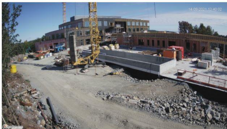
Figur 16. Byggprojektet av Fagelskolen i Agder og Grimstad tannklinik i Norge, bilden är tagen med live-kamera den 14 september 2021 (Agder Fylleskommune, 2021).
