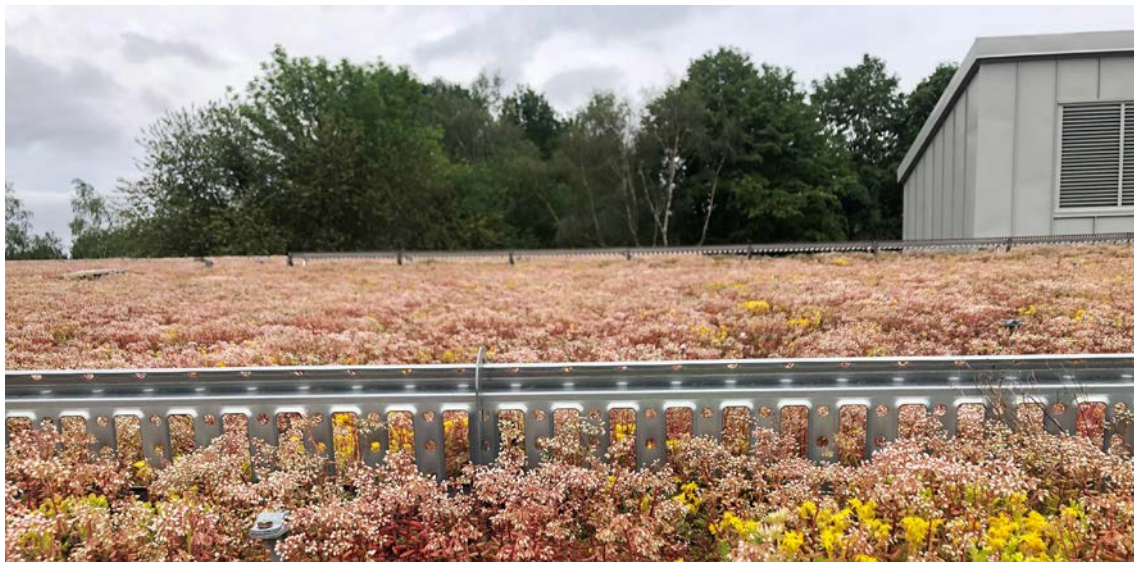
Hela förskolan är försedd med ett sedumtak vilket gynnar dagvattenhanteringen samt den biologiska mångfalden. Bild: Lokalförvaltningen.
