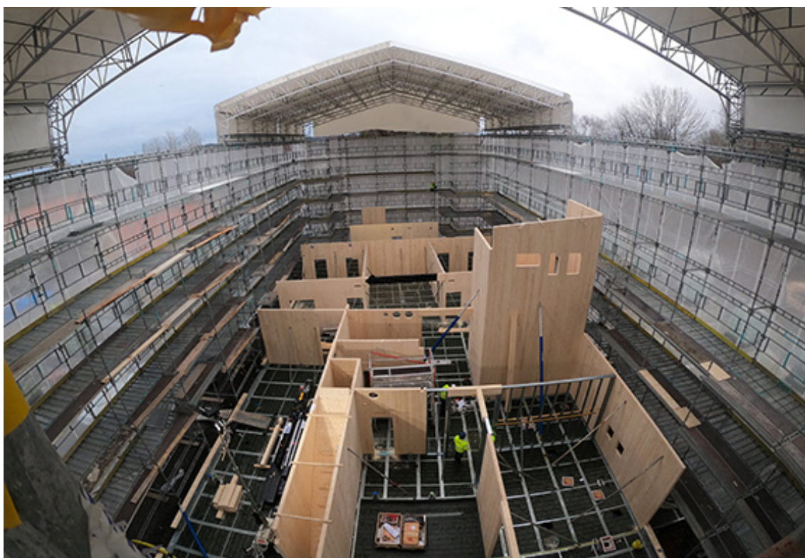
Bilden visar monteringen av förskolans innerväggar bestående av KL-trä. Bild: Derome
