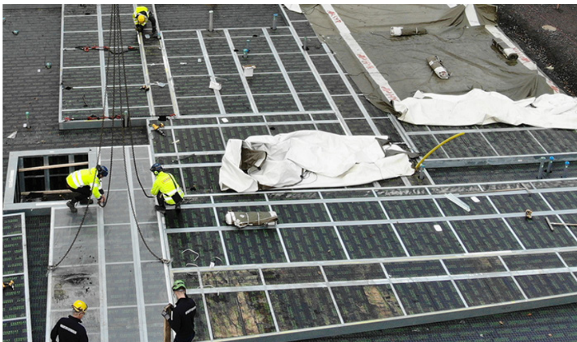
Bilden visar montage av grundelementet som består av cirka 60% återvunnet glas. Bild: Lokalförvaltningen.
