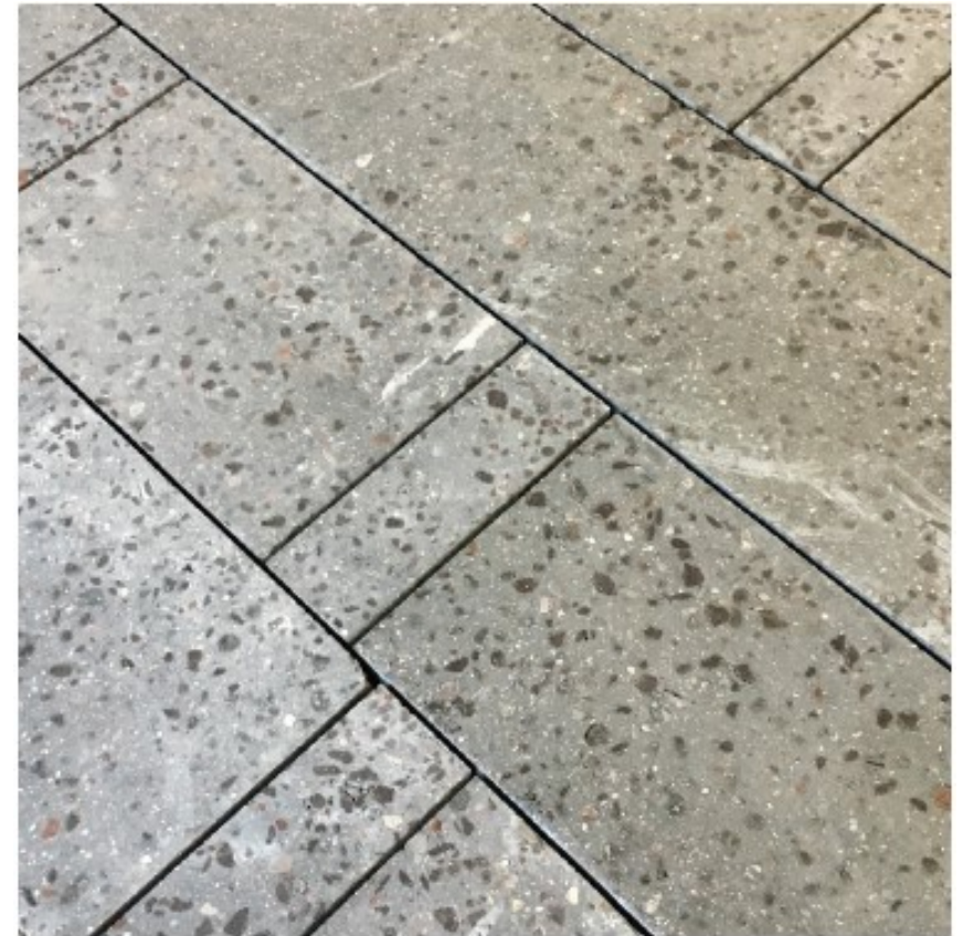
Gulv lavet af nedknust fundamentbeton blandet med glas
