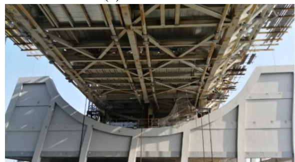
(d) Closure completed
